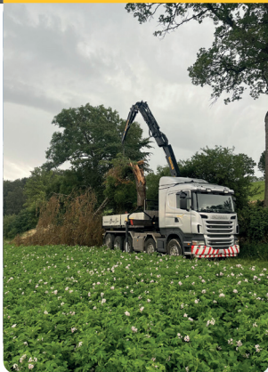
LKW Kran 22m Reichweite
